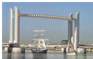
Octobre 2009 : début des travaux du pont devant de Bordeaux
