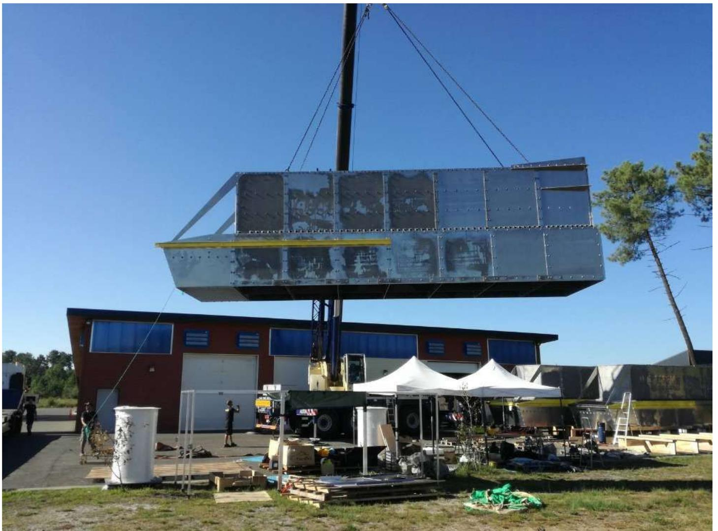
L'un des quatre caissons flottants qui constituent le prototype de houlomoteur.
