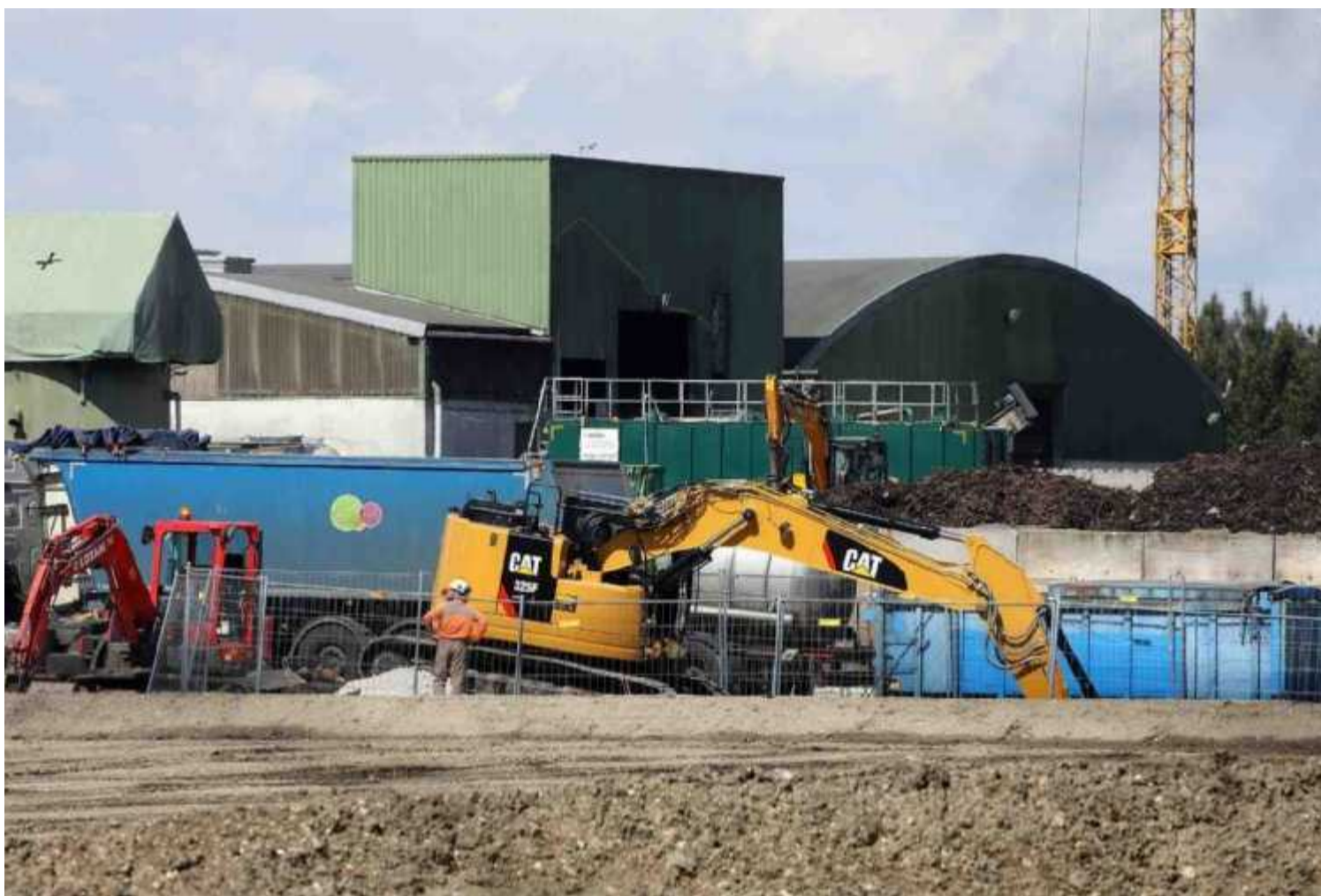
Trois méthaniseurs sont en cours de construction sur le site de Suez Organique, à Saint-Selve, en Gironde. ARCHIVES STÉPHANE LARTIGUE / « SO »
