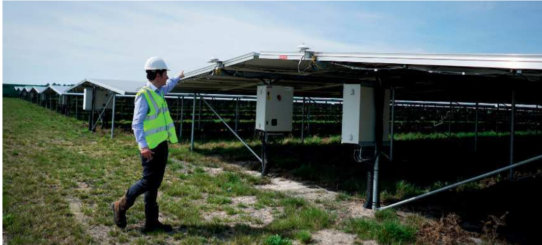
Les panneaux solaires sont posés sur 16 000 tables. Dessous sont installées les boîtes de jonction qui collectent le courant continu. Quotidiennement, sept personnes s'assurent, par une inspection visuelle, du bon état des panneaux et des structures
