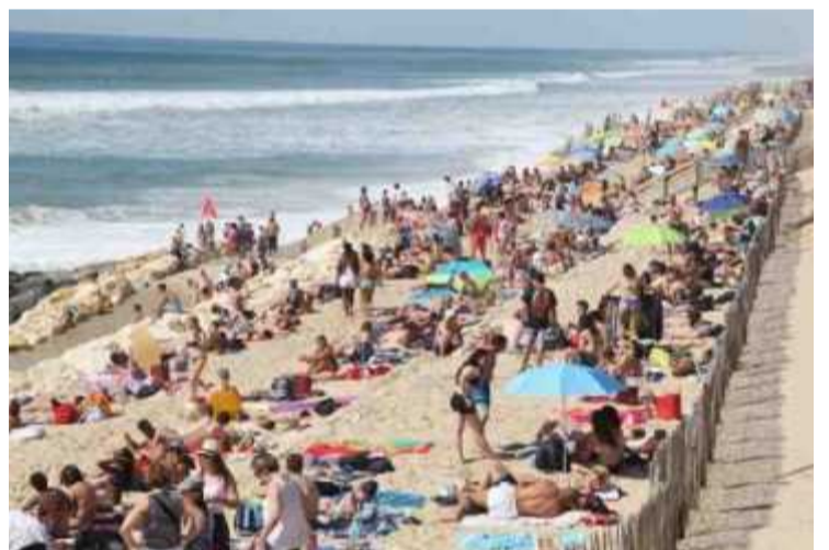
La plage de Lacanau (33), protégée par un enrochement, est régulièrement réalimentée en sable. PHOTO ARCHIVES « SUD OUEST »
