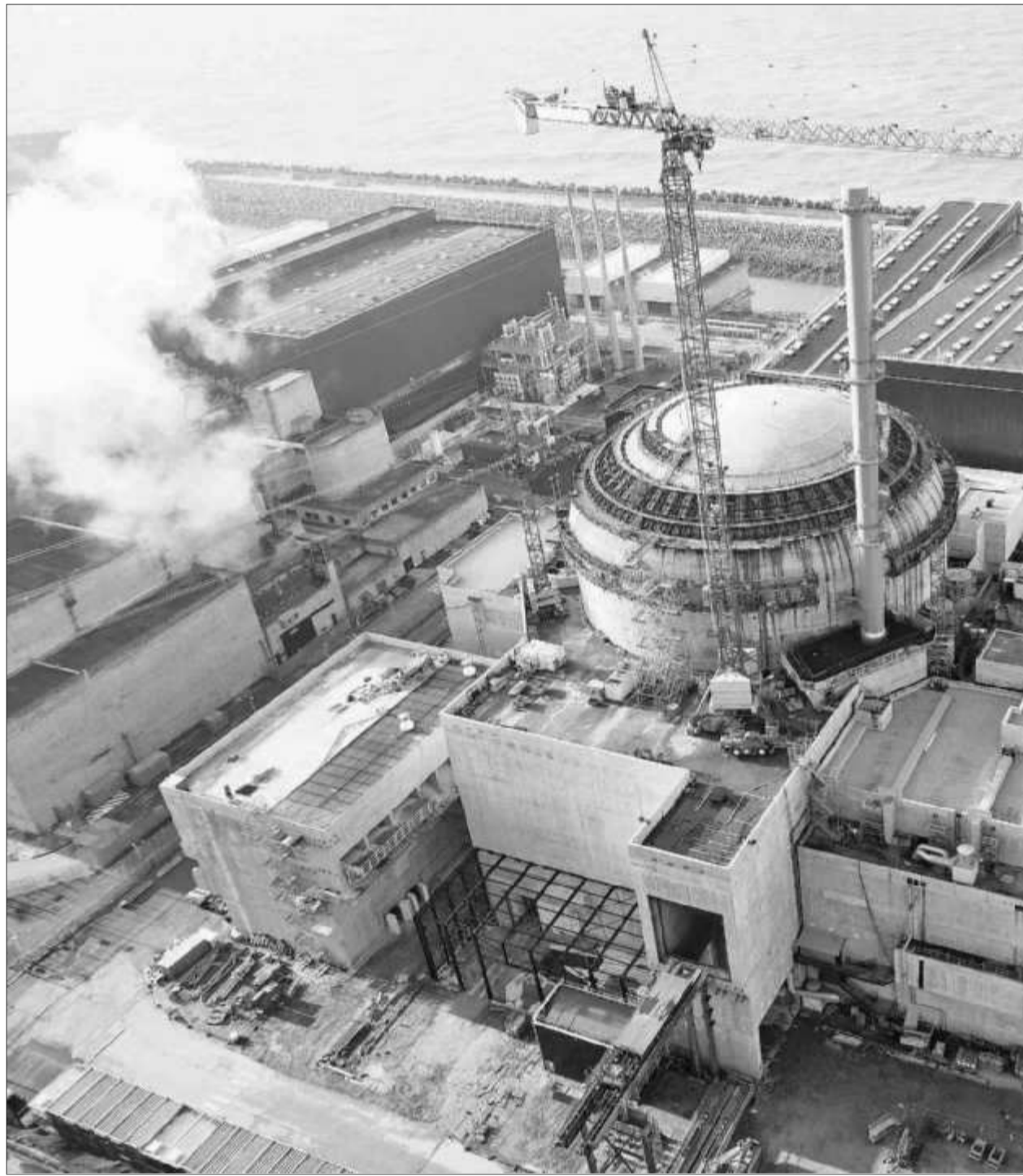
Sur les bords de la Manche, les opérations de génie civil s'achèvent. PHOTO EDF/ALEXIS MORIN
