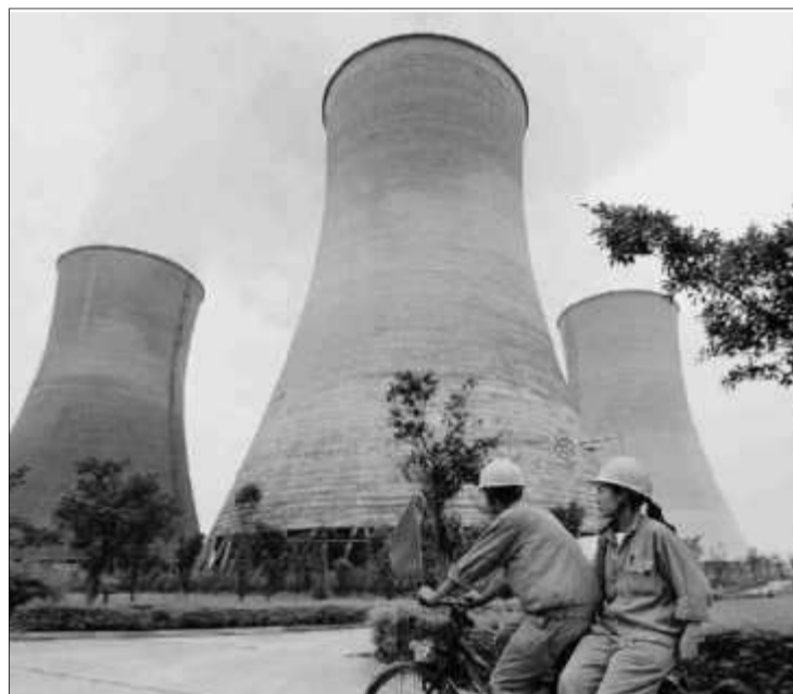
La Chine, qui compte déjà une vingtaine de réacteurs opérationnels (ici la centrale de Guang'an), a lancé la construction de vingt-quatre autres réacteurs. PHOTO AFP
